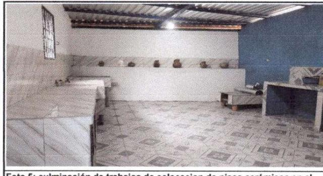
Foto 5: culminación de trabajos de colocación de pisos cerámicos en el ambiente de la cocina, cuneta, levantamiento de pared para evitar filtración de agua.
