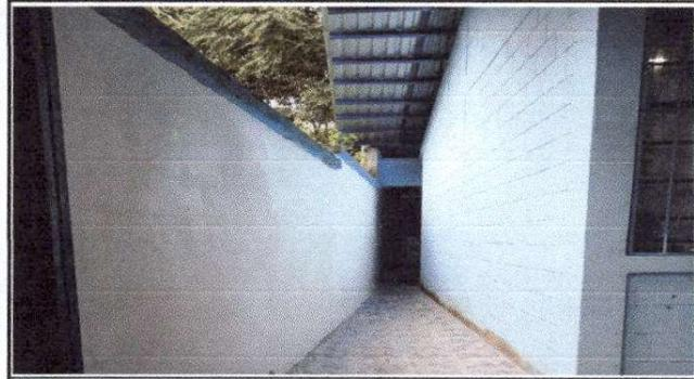
Foto 3: culminación de repello de paredes, colocación de techo de lamina y piso en pasillo para mejorar los ambientes de la escuela.
